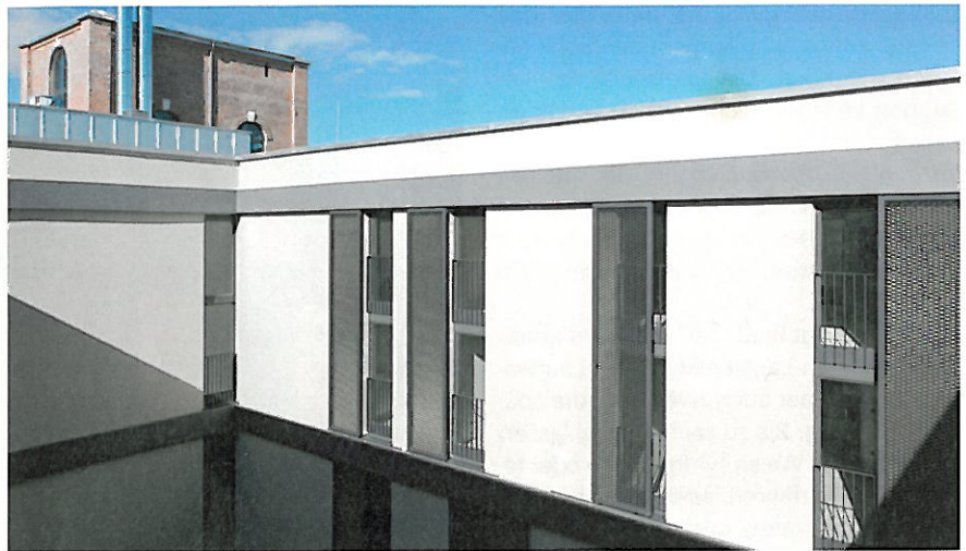
Zweigeschossige Schiebeläden mit Streckmetall als Füllung.
