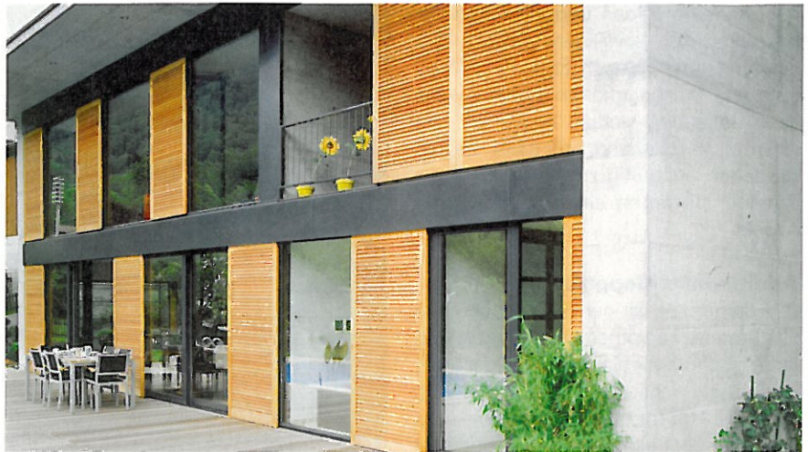
Holz ist für Läden nach wie vor ein beliebtes Material, das als Schiebeläden frisch und zeitgemäß wirken kann.
